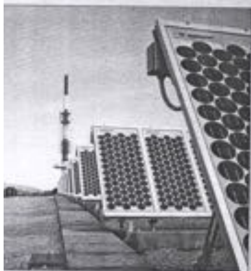
Photo 2 • Batteries de photopiles alimentant un récepteur de télévision.
