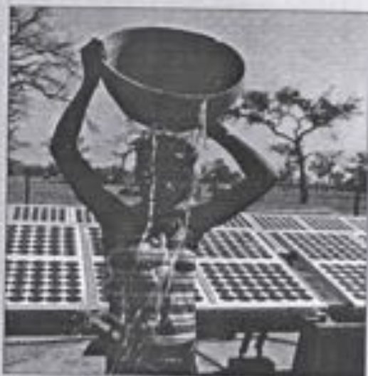
Photo 3 • En Afrique, les photopiles fournissent l'électricité aux pompes qui puisent l'eau du sous-sol.
