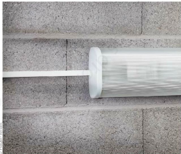
Les boîtes DCL ne sont pas obligatoires si la canalisation est en saillie et si le luminaire dispose de bornes de raccordement (réglette fluorescente, hublot, par exemple).
