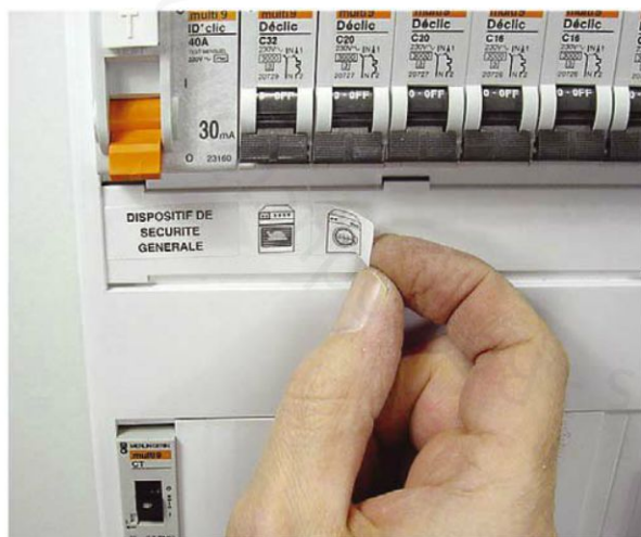
Figure 56 : Exemple de repérage des circuits
