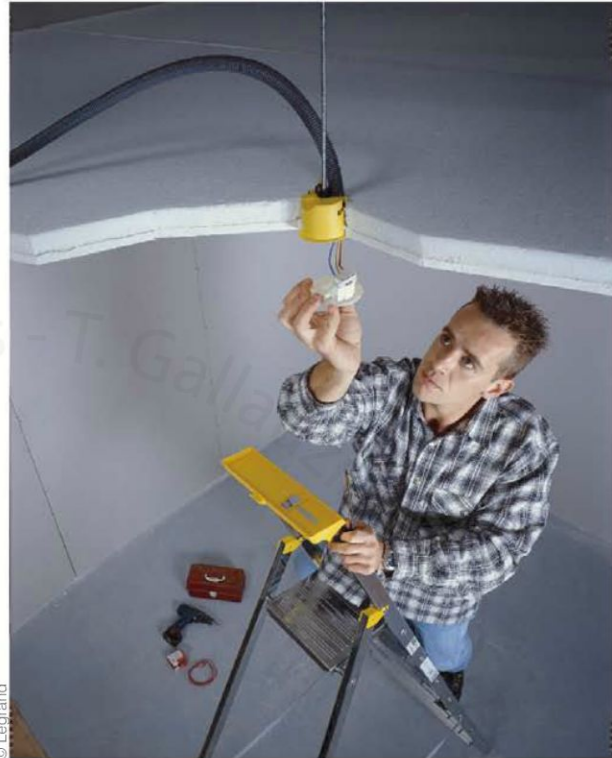
Exemple d'installation d'une boîte DCL. La boîte doit être fixée à la structure du bâtiment (ici à l'aide d'une tige filetée) et pouvoir supporter une charge de 25 kg.
